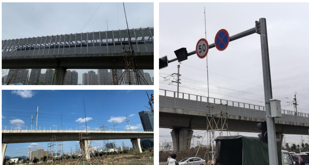
图 2.11 2020 年 1 月温州市域铁路 S1 线路既有线路噪声评估
