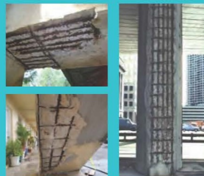
A2 埋置于混凝土中的钢筋镀锌层的局部腐蚀性
