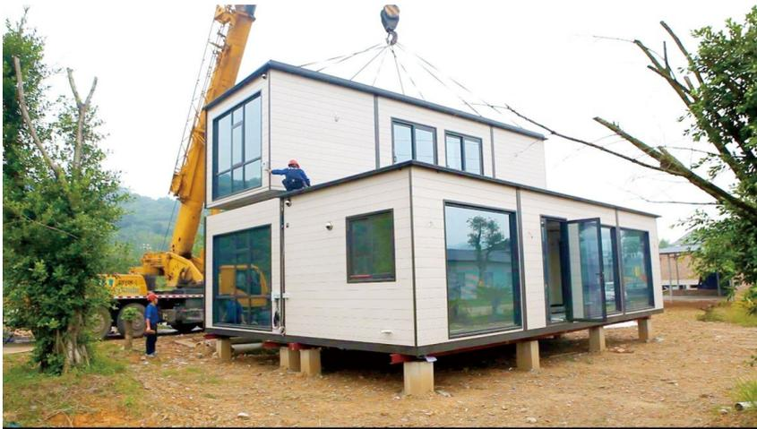
步驟三：將安裝好的組合房屋，進行水電接駁，實現通水通電，達到plug and play的效果。
