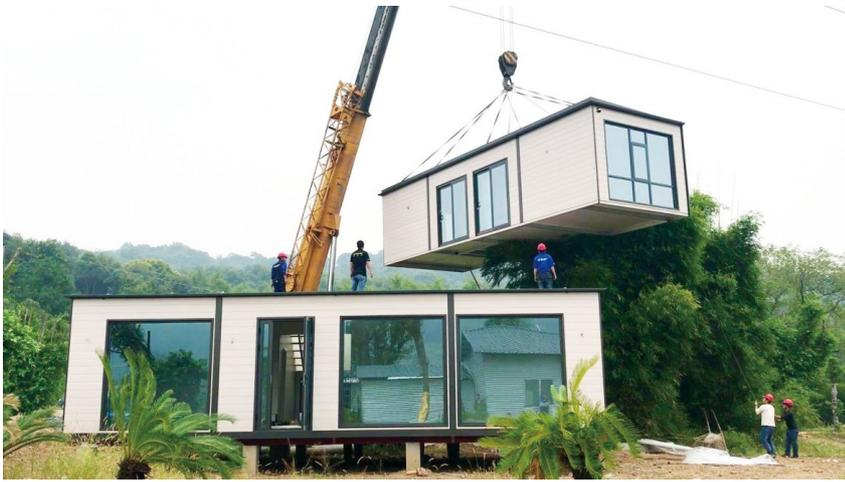
步驟二：通過吊機將每個組件房屋單元吊起，在工地現場進行拼接組合。
