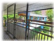
Branch Footbridge to PolyU 轉入理工大學之分支天橋
